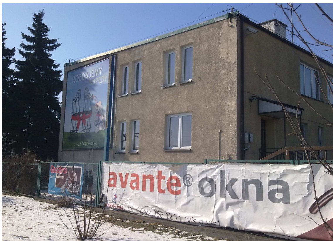
fot. nr 2: elewacja: wschodnia
