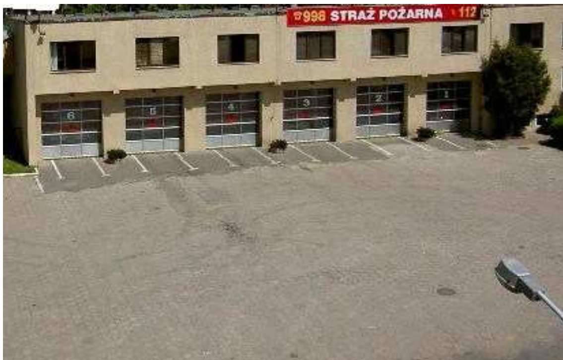
fot. nr 1: elewacja południowa (od strony ul. Gwardii Ludowej)
