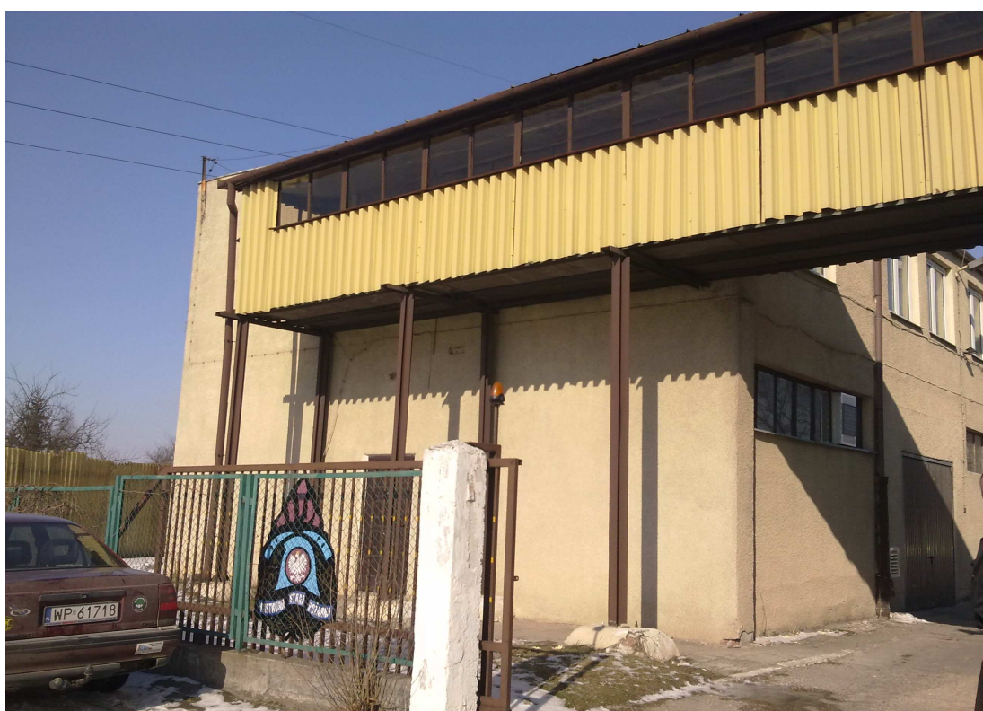
fot. nr 4: elewacja południowa
