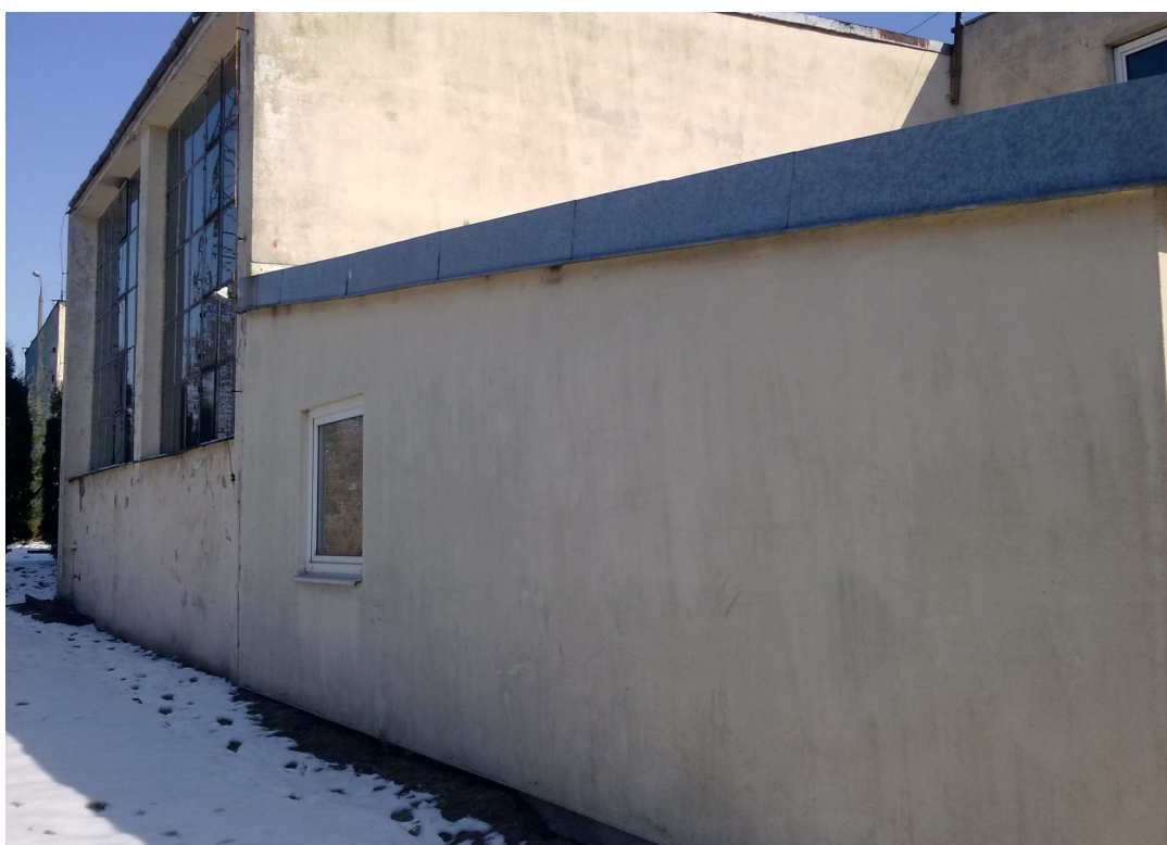
fot. nr 2: część północna elewacji zachodniej
